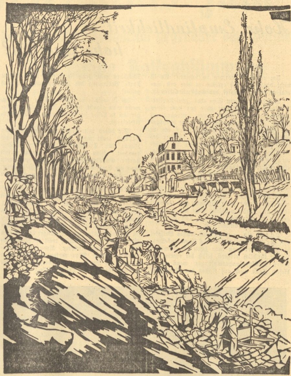
Viele Hände am Werk beim Autobahnbau
