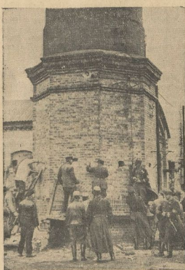
Die Sprengkammern werden gefüllt
