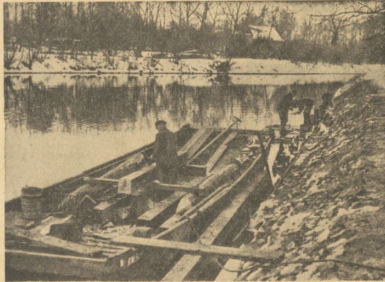
Das Ufer der Saale wird befestigt
