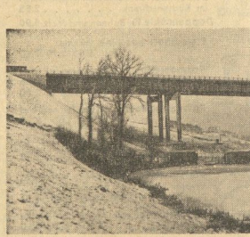
Reichsautobahn-Brücke bei Tautendorf (Thür.) auf der Strecke Eisenberg-Schleizer Seenplatte, die, wie schon mitgeteilt, am Sonnabend dem Verkehr übergeben wird.
