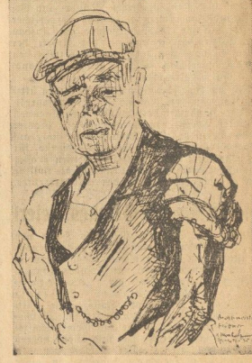
Der Sprengmeister leitet die Arbeit.
