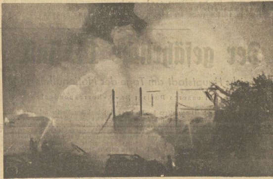
Ein Bild der nächtlichen Brandkatastrophe. Die Umrisse der Feuerwehrleute links vorne geben einen Anhaltspunkt für die Ausmaße des Feuers.
