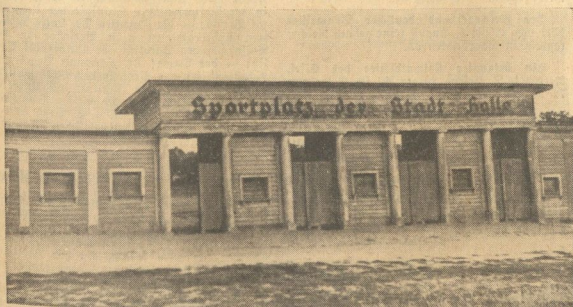
So sah bisher der Eingang zum Stadion Gesundbrunnen aus
