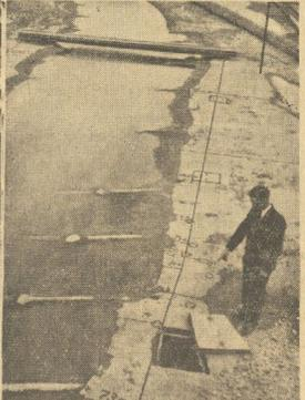
„Die Elbe bei Potsdam.“ Auf dem Versuchslände der Preussischen Versuchsanstalt für Wasserbau und Schiffbau werden für die Verbesserung der Schiffbarkeit der Elbe interessante Versuche gemacht. Hier ist der Elbebau im Maßstab 1:50 aufgebaut.
