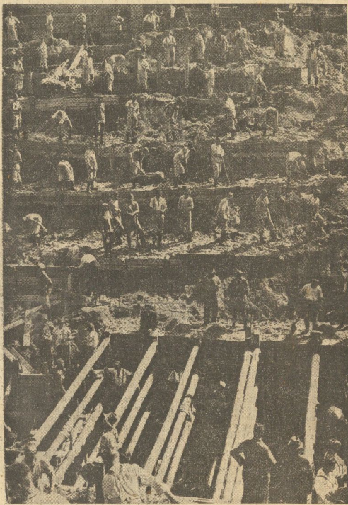
Das Berliner Einsturzungslück. Aufnahme: Kautzsch. Eine Vorstellung von der Schwierigkeit der Rettungsarbeiten beim Schocksteinsturz in der Hermann-Göring-Straße gibt dieses Bild: Es mußten erst Terrassen zur Befestigung des Sandes angelegt werden, ehe man in die Tiefe dringen konnte.
