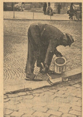
Schon im Laufe des Tages wurden überall die Bordkanten - wie hier bei der Verkehrsinsel am Leipziger Turm - durch weißen Farbanstrich besser sichtbar gemacht
