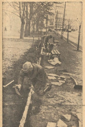
Die Anlagen am Steinplatz erhalten eine schöne Seilantenneneinfassung, nachdem...
