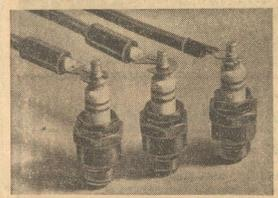
In Kleinigkeiten zeigt sich am besten der Fortschritt. Diese Gegenüberstellung von Kabelschalen für Zündkerzen bisheriger Ausführung (links und Mitte) und jetziger Bauart (rechts) zeigt augenfällig die Vereinfachung und Verbesserung. Der kleine Draht-Kabelschuh erfüllt seinen Zweck genau so gut, obgleich er mit weniger Werkstoffaufwand und deshalb wesentlich billiger hergestellt werden kann.
