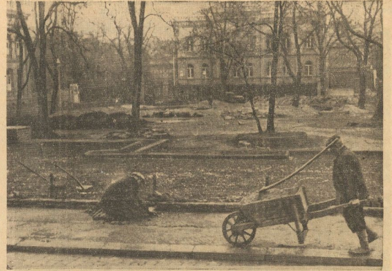
Der Kinderspielplatz an der Christian-Thomastus-Schule geht seiner Fertigstellung entgegen
