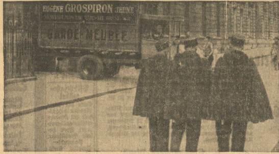
Die Angeklagten mit ihren Angehörigen. Die Angeklagten sind hierhergeführt, vor der Uebernahme der Pariser Botschaft durch die Nationalpolizei alle beiseite zu schaffen, was irgendeine Belastung darstellt. Hier verläßt ein vollbeladener Möbelwagen das Gebäude, das in weitem Umkreis abgesperrt ist.
