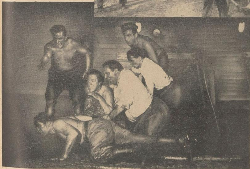
Oben: Ein Senkkasten sackt weg. Die durch die großen Stahlzylinder in den Caisson einstiegen, sind geteufelt. — Unten: Der in den Senkkasten einbrechende Schlamm bringt Todesgefahr. — Mitte: Reichsautobahnbau zwischen Halle und Berlin usw.: usw.
