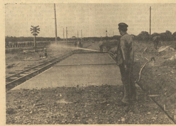
Süick für Süick der Betondecke wird fertiggestellt
