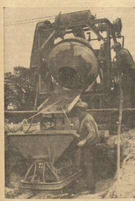
Die Zementmischmaschine steht nicht still
