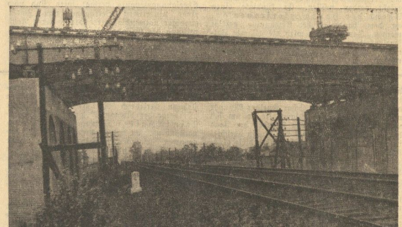
Dicht bei Halle, zwischen Diemitz und Peißen überquert die Reichsautobahn die Eisenbahnstrecke Berlin. Die Brücke der Reichsautobahn über die Bahnstrecke ist in ihrem Eisenkonstruktionsbau bereits fertiggestellt.
