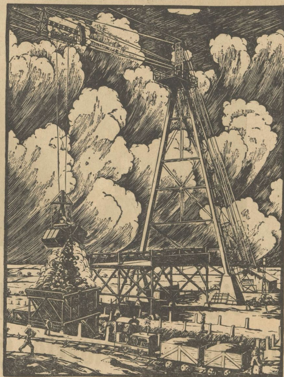
Krananlage in den Wildschützer Steinbrüchen bei Torgau Originalholzschnitt von Hannes Thierbach
