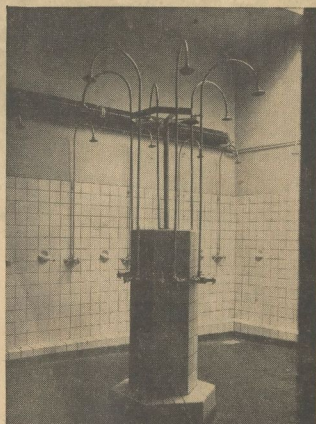
Teilansicht der Waschräume
