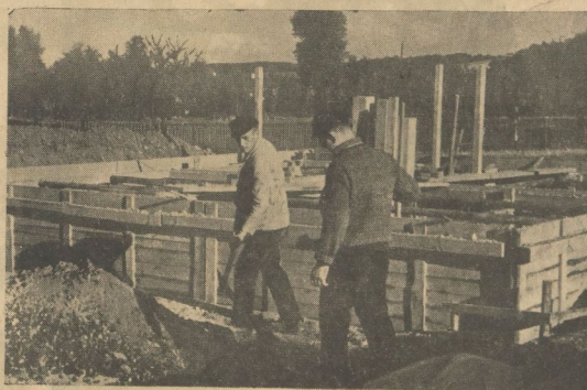
Das Eigenheim ist im Entstehen
