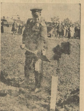
Generalmajor Schwub beim ersten Spatenstich
