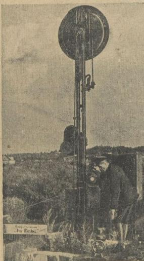
Bild links: Gleissicherung. Neben elektrischer Beleuchtung werden für die Signale auf der Strecke auch noch Petroleumlampen verwendet. — Bild Mitte: Das Stellwerk. Von hier aus wird der gesamte Verkehr des Bereiches reguliert. — Bild rechts: Gleissicherung. Große Signalbrücken, die von den Hauptstellwerken bedient werden, sichern die Bahnhöfe,
