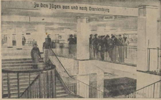
Blick in das unterirdische Zwischengeschoss über den eigentlichen Bahnsteig, das das gefahrlose Passieren des Potsdamer Platzes über neun verschiedene Eingänge gestattet
