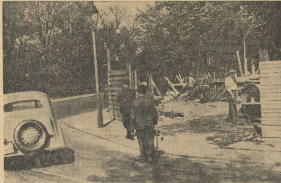
Die Mauer des Hofjäger-Gartens wird sechs Meter zurückgezogen
