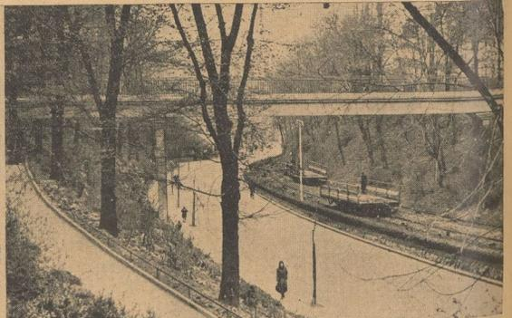
Die Drahtseil-Eisenbahn, die den Fuhrwerken einen beträchtlichen Höhenunterschied überwinden hilft, und einer der beiden alten Schaffner
