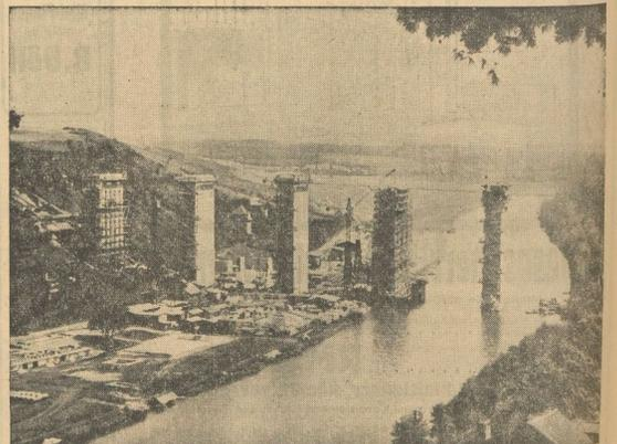
Gegenwärtig wird bei Limburg eine 525 Meter lange und 63 Meter hohe Reichsautobahnbrücke gebaut. Im Sommer des nächsten Jahres soll diese Brücke fertiggestellt sein
