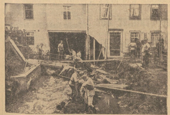
Wohnhaus Infolge wolkenbrucharziger Regenfälle wurde die Gegend von Wernsdorf von Ueberschwemmungen heimgesucht. Die Fluten des reißend angeschwellten Dorfbaches von Leukersdorf unterspülten u. a. dieses Wohnhaus, das geräumt werden mußte.
