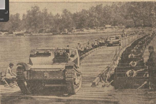
Der Uebergang leichter Panzerwagen über eine von Pionieren über den Tessin erbaute Pontonbrücke während der großen italienischen Manöver in der Po-Ebene
