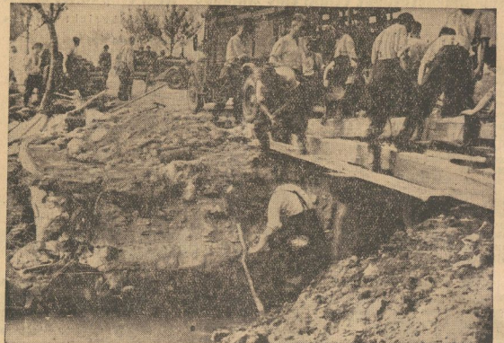
Pioniere bei der Wiederherstellung einer von den Polen vor ihrem Abzug gesprengten Brücke
