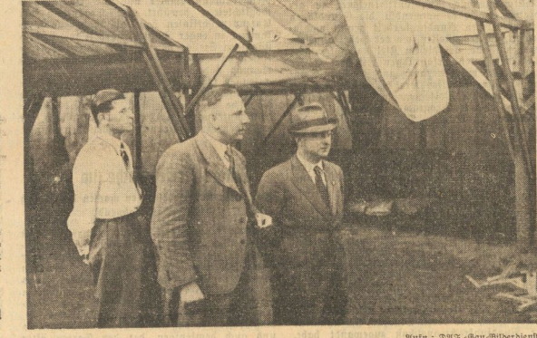
Gauleiterstellvertreter Tesche und Gauamtsleiter Lamming in der fast fertiggestellten Kfz.-Halle auf dem Universitätssporplatz
