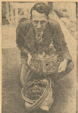
Der englische Schiffsingenieur Ronald T. G. Mason führte seine neue Erfindung, den Lebensrettungsball, vor. Es ist, wie das Modell erkennen läßt, eine Kugel, deren Inneres mit den Sitzbänken sich unabhängig von den Schwankungen der Außenhaut stets im Gleichgewicht hält. Der Durchmesser der Kugel beträgt etwa vier Meter und soll für die Besatzung eines Frachtdampfers ausreichen
