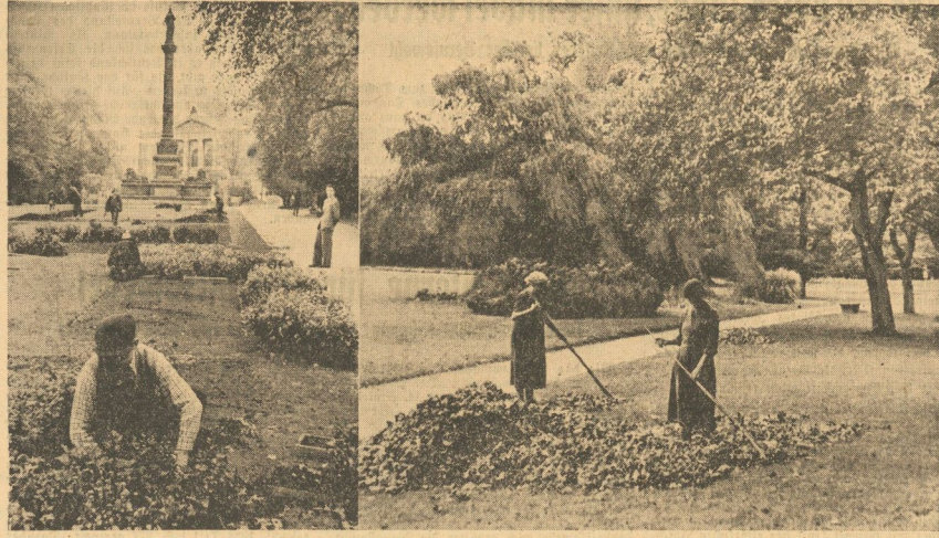
Nun ist der Sommer endgültig vorbei. Winterasern werden in den städtischen Anlagen zwischen Post und Theater gepflanzt und im Gimmritzer Park häuft sich wie überall das gefallene Laub zu Bergen.
