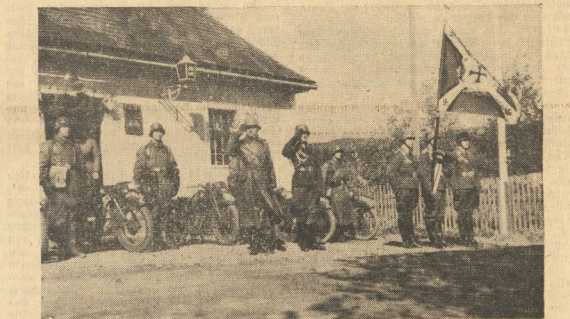
Der Kommandeur der 11./Flakregiment 33, Oberstleutnant Pavel, nimmt den Vorbesuch am deutschen Zollhaus in Schwarzach ab
