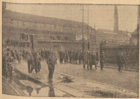
Bau: Denain-Müllfabrik (A. J.)
