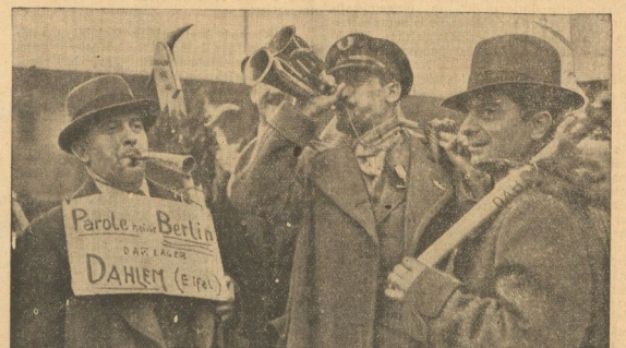
Von den Arbeiten an der Westbefestigung zurück: In Berlin trafen jetzt die ersten Züge mit Arbeitern ein, die beim Bau der Westbefestigungen eingesetzt waren. Parole „Heimat“ ruft auch hier, wie man sieht, die freudigste Stimmung hervor
