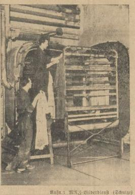
Im Heißluftkessel hängen die Kleidungsstücke.
