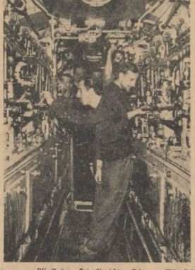
PK-Wa. in. Kriegsberichterstatter Schwatz (Atlantik) Auf engstem Raum laufen hier unzählige Röhren, Leitungen und Ventile der Dieselanlage in einem Unterboot der deutschen Kriegsmarine zusammen. Für den Laien ein unent-wirrbares Durcheinander, für den Fachmann eine äußerst sinnreiche Konstruktion. Die Dieselmotoren müssen ständig über zwei Diesel überwachen, denn von ihrem ununter-brechen Arbeiten hängt alles ab.
