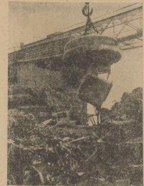
Mit Hilfe schwerer Elektromagneten wird das Schrott aus Känen und Güterwagen ausgeladen und dann von den Plätzen aus wieder zu den Schmelzöfen geschickt.
