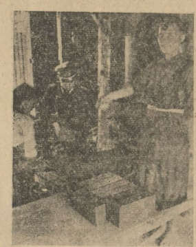
Wärmedach. Die Ziegel werden sofort wieder in Betrieb genommen. An dieser, eben wieder aufgetragenen Ziegelsteinserie arbeiten Einheimische unter Anleitung eines sachkundigen Offiziers.
