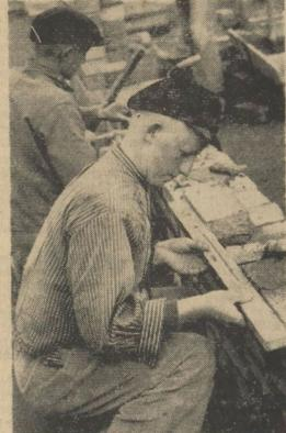
Mit der Wasserwaage prüft der Maurer seine Arbeit
