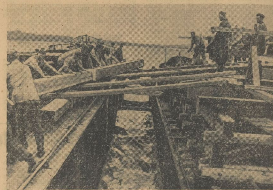
Über die Donau Ein auf zwei Schleppern gebautes Teilstück der Brücke wird herangezogen und eingesetzt
