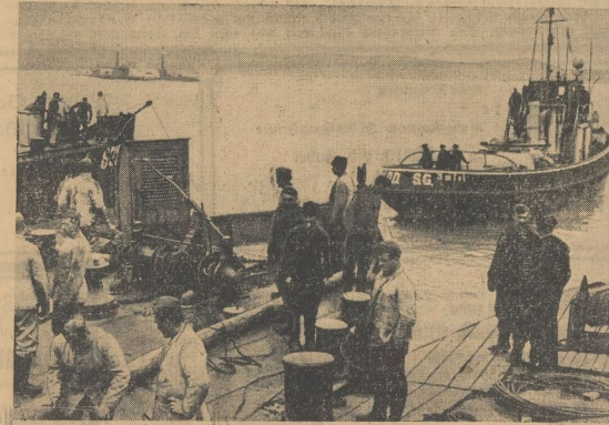
Unsere Aufnahme ist ein neues Bild von dem Brückenbau für den Übergang unserer Truppen nach Bulgarien. Über die Donau wird ein auf Schleppern gebautes Teilstück für den Brückenbau herangezogen und angesetzt
