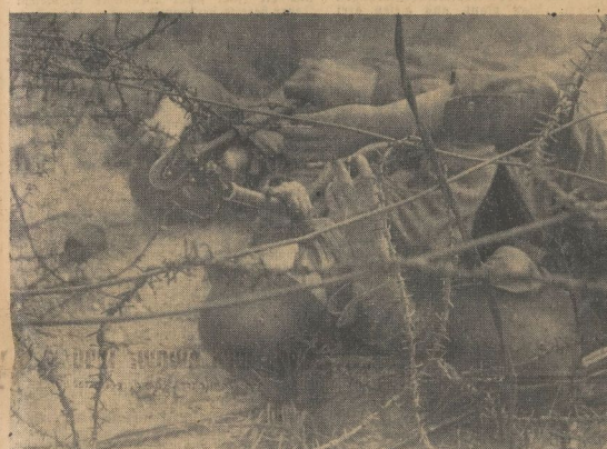
Auf dem Rücken liegend schneiden Pioniere eine Gasse in die Drahtsperrung.
