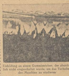
Eisabwäpplage an einem Gummielement, der absichtlich nicht eingeschaltet wurde, um das Verhalten der Maschine zu studieren
