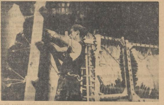
Die in Holzrahmen eingespannten Kalbfelle werden stundenlang mit dem Scheibstein bearbeitet
