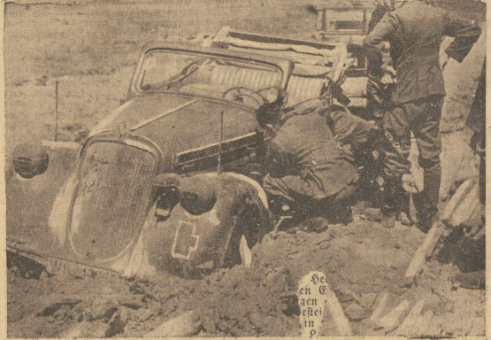
Und trotzdem geht der Vormarsch weiter! Hier war der Kraftwagen auf der Straße völlig stecken geblieben. Aber durch Einsatz aller Kräfte konnte er wieder herausgezogen werden.
