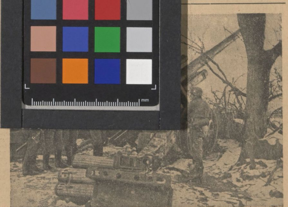
An der Westfront Geschütz in Feuerstellung. Der Verschuß ist geöffnet, das Geschöß wird mit dem Ansetzer angesetzt
