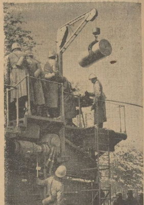
Hochwinden schwerer Kartuschen Aufgenommen bei den deutschen schweren Geschützen
