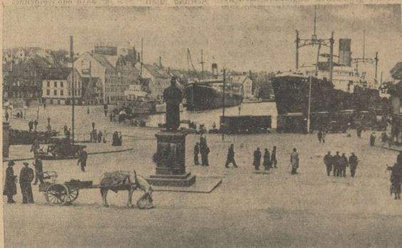
Bis weit in das Innere einer norwegischen Hafenstadt erstrecken sich die Wasserarme, die selbst noch für große Fracht- und Personendampfer befahrbar sind. Das Straßenbild zeigt, daß das Leben hier bereits wieder seinen gewohnten Gang geht
