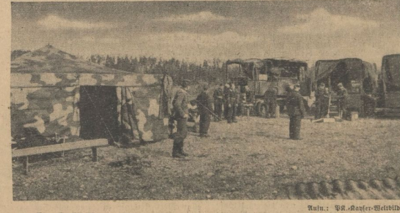
Eine Staffel Heeresaufklärungsflieger ist auf dem Flugplatz von Oslo eingetroffen. Die durch Schiffe herbeigebrachten Material- und Werkstatwagen und das Unterquartzell sind schnell aufgebaut. Sofort wird mit den stets notwendigen Ueberholungsarbeiten begonnen
