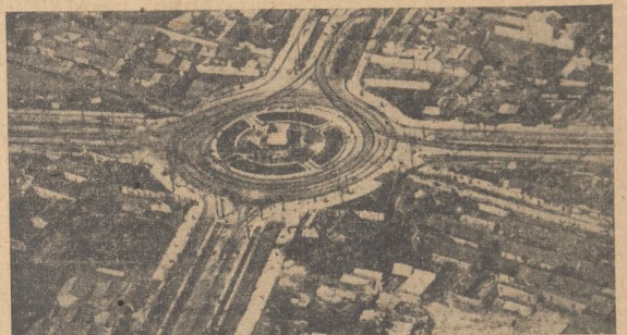
Blick auf einen Hauptverkehrsplatz Nankings
