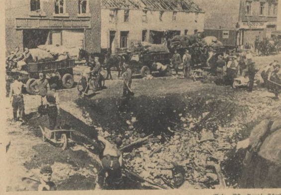
(Wajn.: FR. - Rump - Ebert.) Straßensprengungen sollten deutschen Vormarsch aufhalten Die Sprenglöcher sind metertief. Soldaten und Bauteilungen, die den vorgehenden Truppen auf dem Fuße folgen, sind dabei die Sprengtrichter auszufüllen
