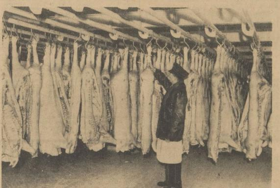
Im Einfrier-Raum wird die Temperatur der aufgehängten Schweinehälften gemessen
