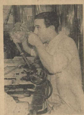
Man: W. J. J. Bitterlich (Schulte) An eine fertige Glaslupe werden Zu- und Abflüsse gesetzt
