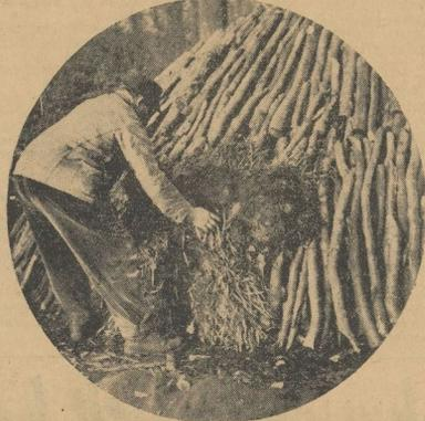
Ganze ist kreisrund und mößt sich nach oben etwas ab. In der Mitte des Meilers wird leicht brennbares Material, wie trocknes Farnkraut, in einer Mähre eingebaut und entzündet. Nachdem das Holz richtig im Brand geraten ist, deckt man weiter Erde auf, damit das Feuer im Meiler möglichst wenig Luft bekommt. Das Holz soll ja nicht zu Asche verbrennen, sondern es soll schwelen.
